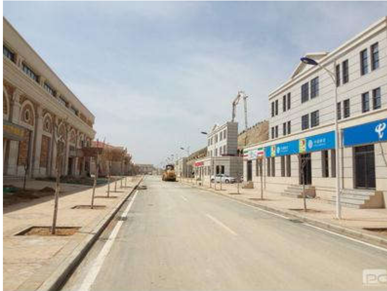
反恐、特警、治安、交通专业仿真实训街区
